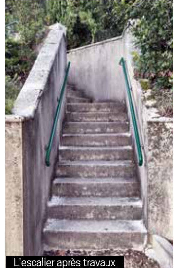
L'escalier après travaux
